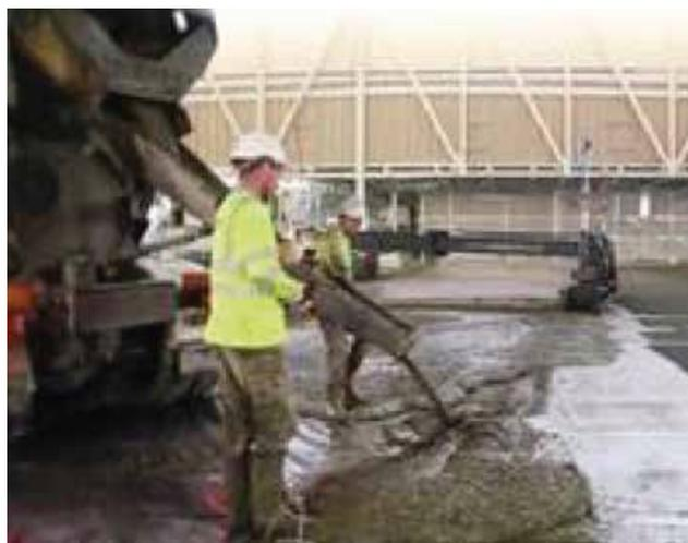
Vertido de concreto con fibras de acero y (al fondo) equipo de última generación Laser Screed para el nivelado de concreto.
