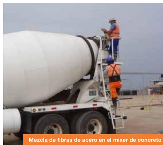
Mezcla de fibras de acero en el mixer de concreto
